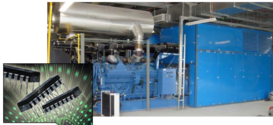
Infineon Power Fab Kulim 6 x 2000 kVA USV (6,6kV) 2 x 2250 kVA ESV (6,6kV)
