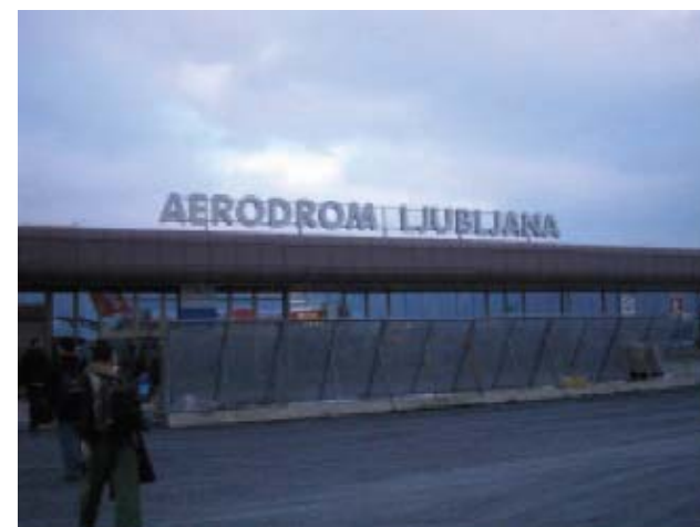
International Airport Ljubljana 1x 500 kVA
